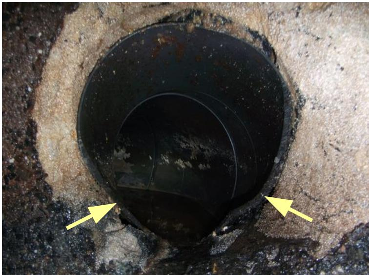
**Bild oben:** wie damals üblich...Rohreinführung OHNE Lippendichtung oder Rohrfutter, sondern lediglich eingemörtelt. Schrumpf- und Setzungsfugen sind die Folge!
